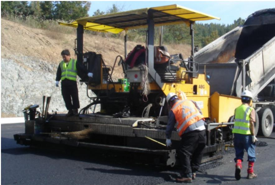
〈그림 1.2〉 아스팔트 페이버(Asphalt Paver)
