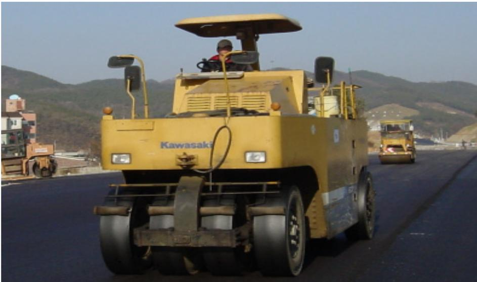
〈그림 1.3〉 타이어롤러(Pneumatic Tire Roller)
